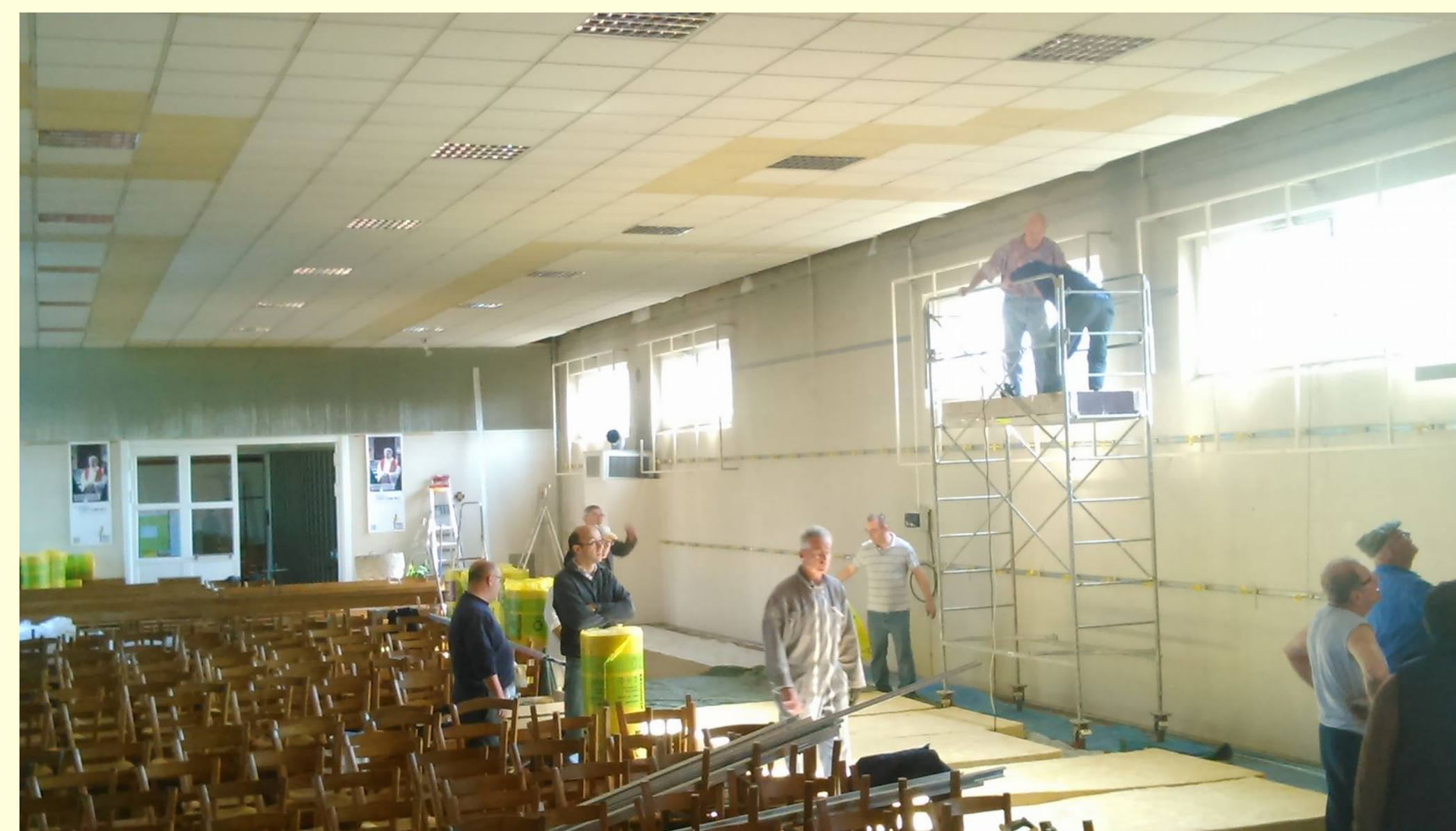
En bas, une vue des travaux en cours
