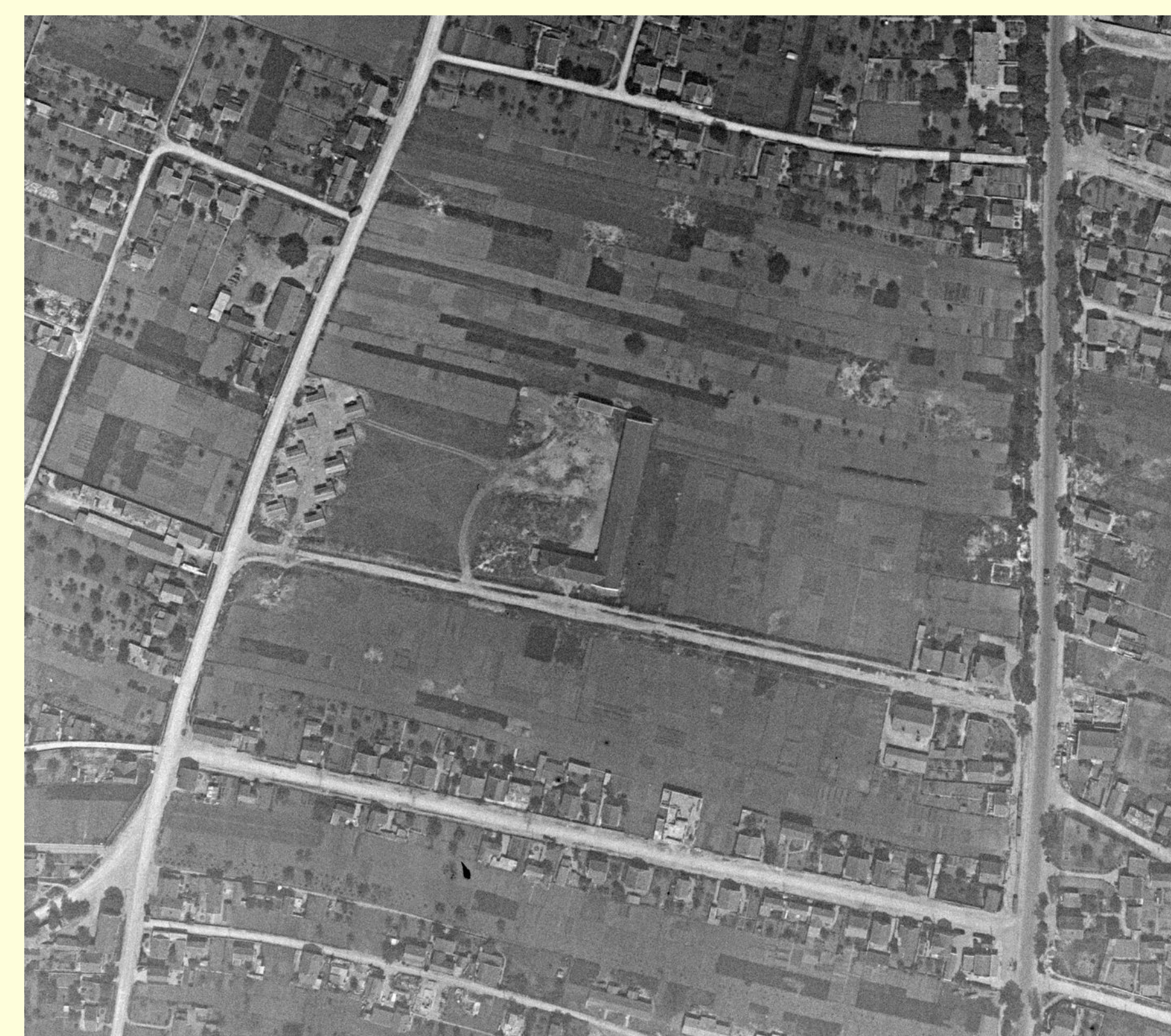
Photo aérienne IGN de 1946. Le Bd Bazin et la rue de l'Arbre Pin n'existent pas. La rue Louis Curel n'est pas goudronnée ; elle n'est bâtie qu'au carrefour avec l'avenue Carraz, à droite. Les dix baraques destinées à reloger les sinistrés sont visibles à l'intersection des rue Louis Curel et Maxime Guillot.
